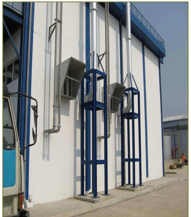
Gia công ống khói tại công trình bosh Chimney processing at bosh project
