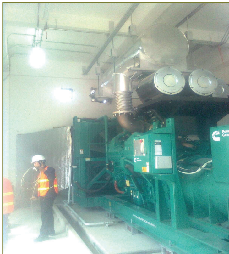
Cách âm phòng máy phát Soundproofing the generator room
