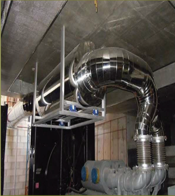
Lắp đặt hệ thống thoát khí Install the exhaust system.
