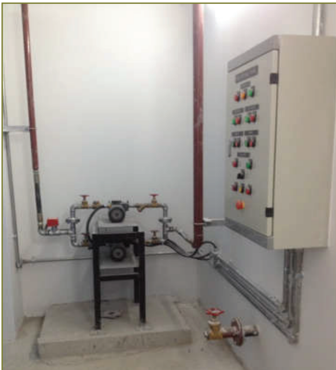
Hệ thống bơm dầu Oil pump system
