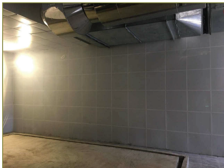
Cách âm phòng máy phát Soundproofing the generator room
