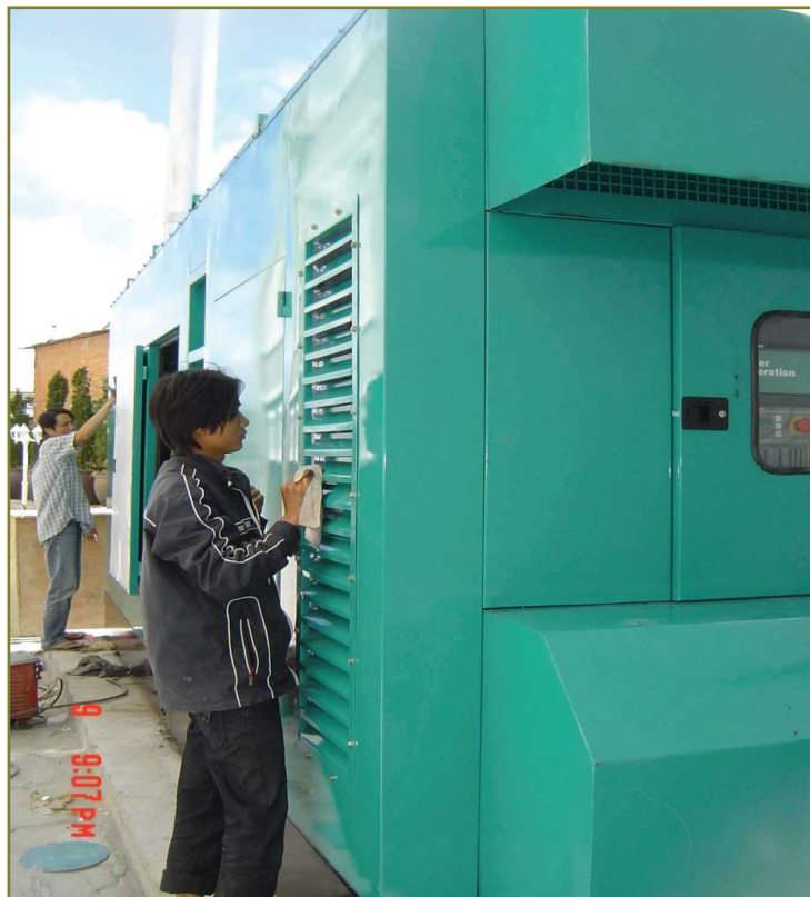
Cách âm phòng máy phát Soundproofing the generator room
