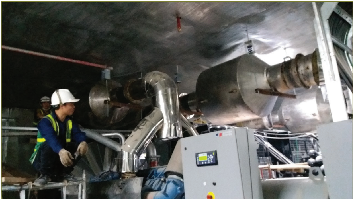
Lắp đặt lọc khói cho công trình 67 Thụy Khuê - Hà Nội Installing catalytic converters for project 67 Thuy Khue - Hanoi
