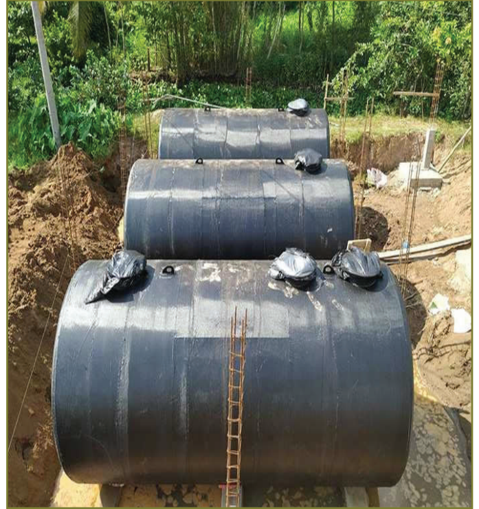
Lắp đặt bồn dầu Install oil tank
